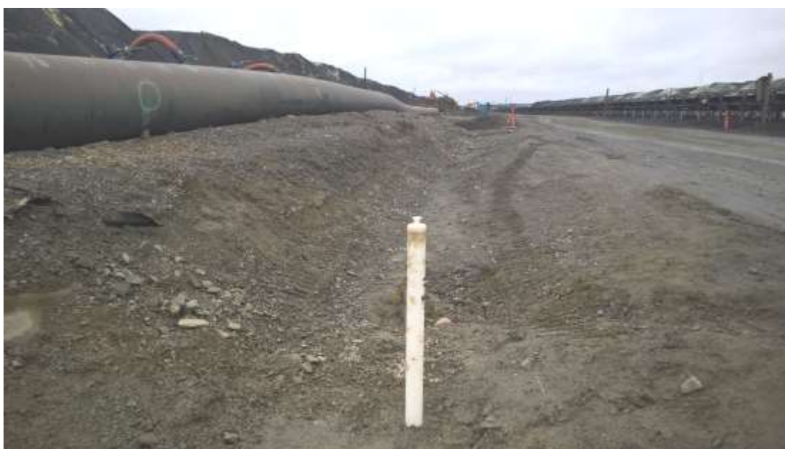
Kuva 15. Putki TF2. Kuvaussuunta luoteeseen.
