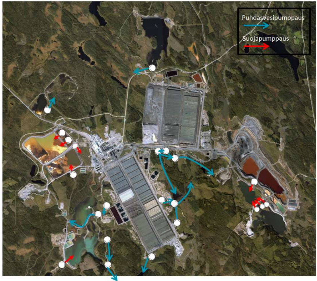
Kuva 7. Suojapumppaukset (suotovesi) ja puhdasvesipumppaukset (TerraFame Oy).
