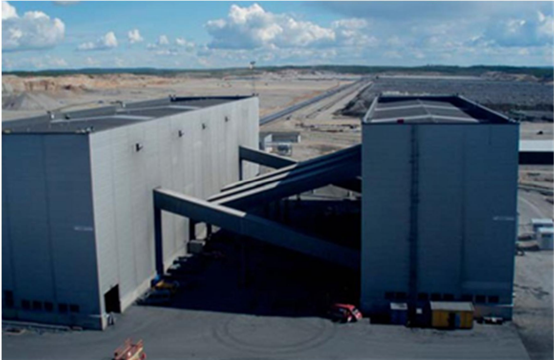
Kuva 3-6. Seulonta ja hienomurskaamo (Ramboll Finland Oy 2012).
