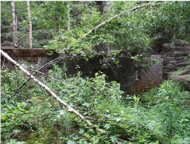
Alakohde 21-1 navetta, kuvattu etelään.
