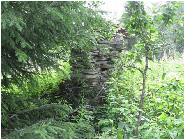
Alakohde 29-1, savupiippu (johon nojaa vanha polkupyörä).
