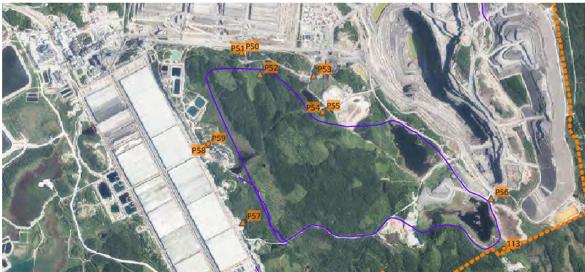
Kuva 3-24. Sivukivialueen KL1 alueen tarkkailuputket. Kallioputket merkattu kolmiolla ja maaputket ympyrällä.
