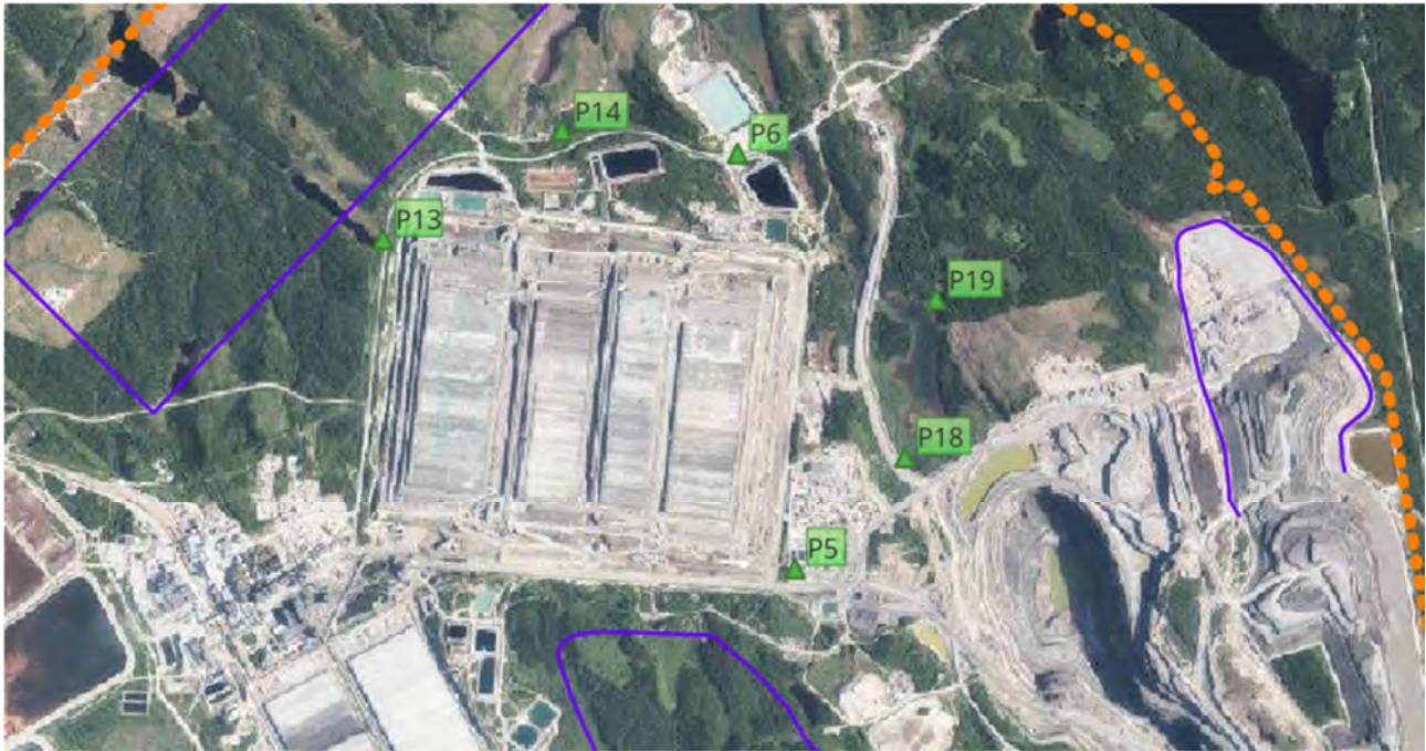
Kuva 3-17. Sekundäärilentä alueen pohjaveden tarkkailuputket. Kallioputket merkattu kolmiolla.
