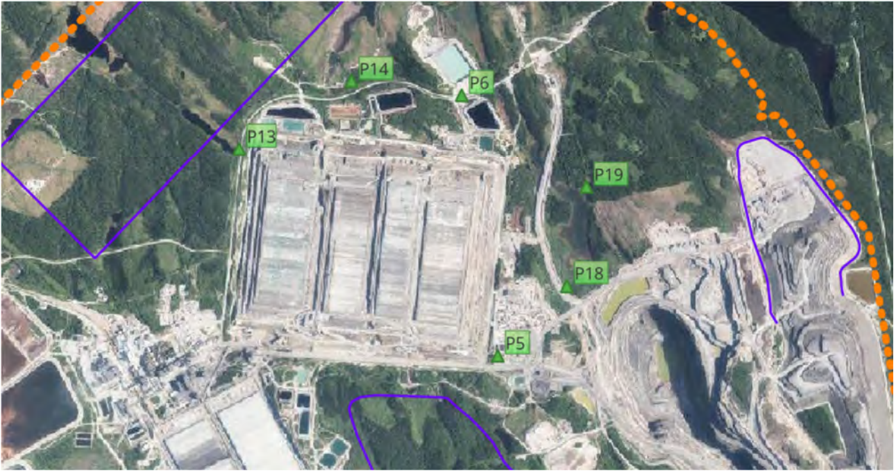
Kuva 3-13. Sekundäärikentän alueen pohjaveden tarkkailuputket. Kallioputket merkattu kolmiolla.
