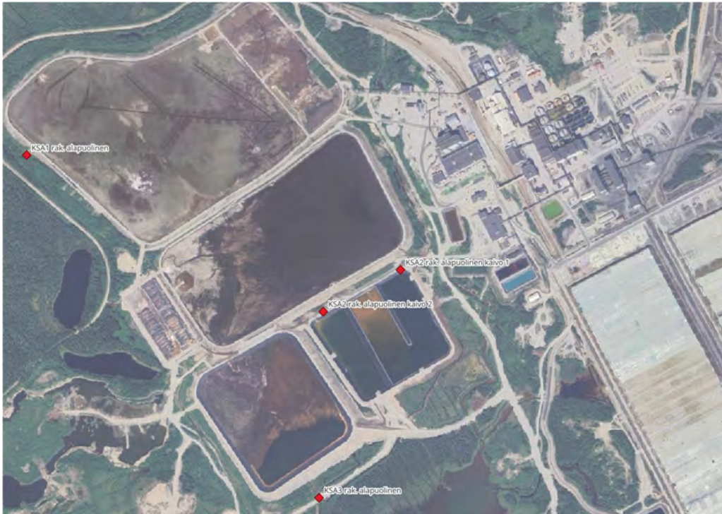
Kuva 3-7. Kipsisakka-aldaiden tiivisrakenteiden alapuolisten vesien tarkkailupisteet
