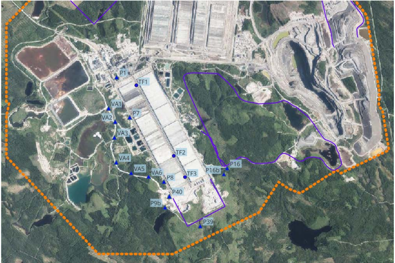
Kuva 3-4. Tehdasalueen ja primäärkentän pohjaveden tarkkailupisteet. Kallioputket merkattu kolmiolla ja maaputket ympyrällä.
