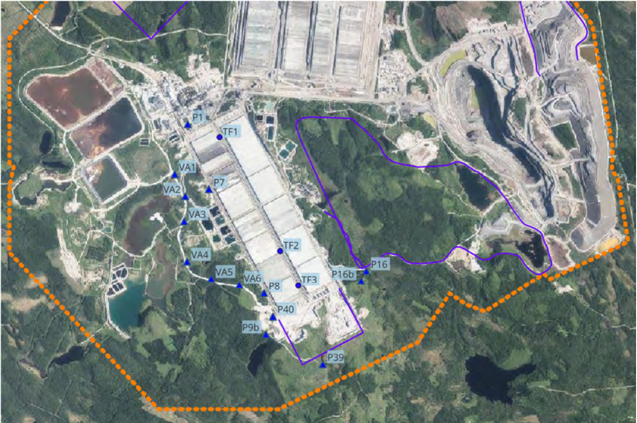
Kuva 3-5. Tehdas- ja primäärikentän alueen tarkkailuputket. Kallioputket merkattu kolmiolla ja maaputket ympyrällä.
