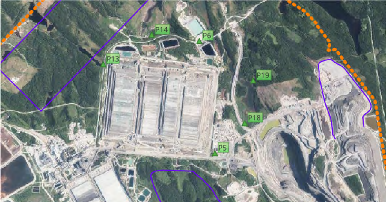
Kuva 3-17. Sekundäärikentän alueen pohjaveden tarkkailuputket. Kallioputket merkattu kolmiolla.
