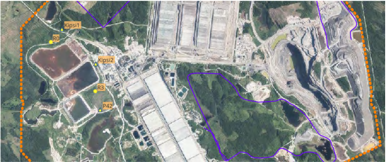
Kuva 3-13. Kipsisakka-altaiden alueen pohjaveden tarkkailuputket. Kallioputket merkattu kolmiolla ja maaputket ympyrällä.
