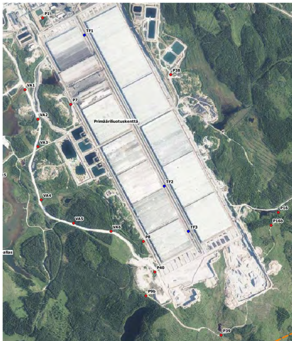
Kuva 3-4. Tehdasalueen ja primäärikentän pohjaveden tarkkailupisteet.
