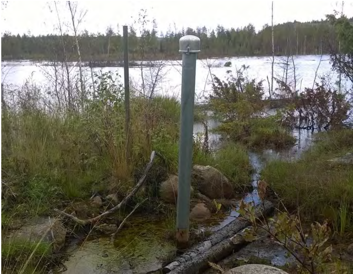
Kuva 3-3 Tarkkailuputken R5 taustalla näkyy Korttelammen patoallas 1.9.2015 (Kuva: Pekka Haaranen)
