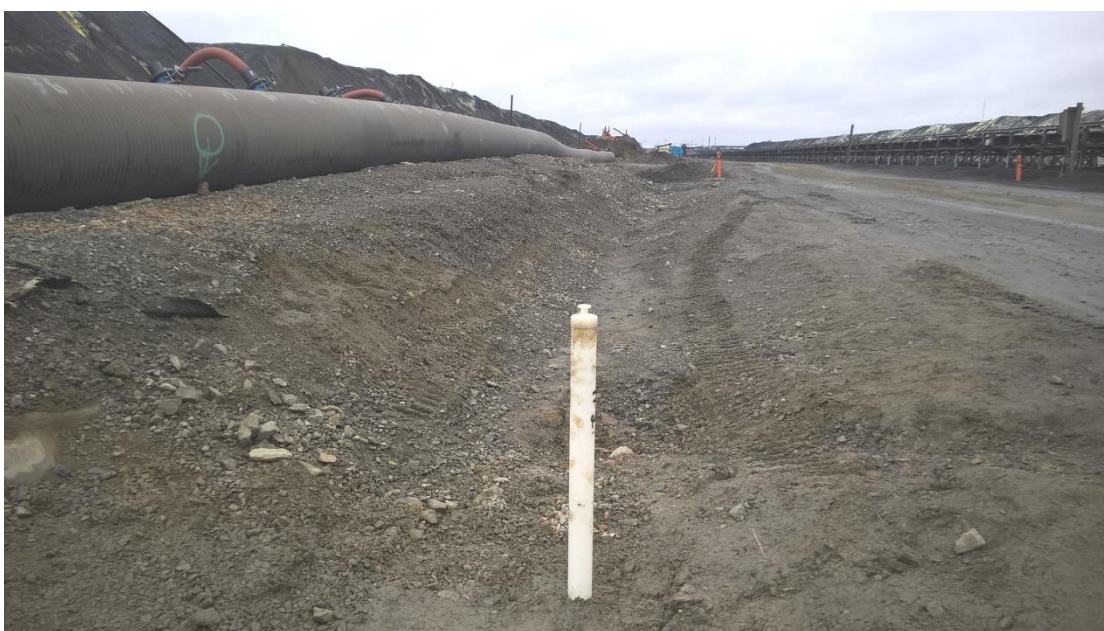
Kuva 15. Putki TF2. Kuvaussuunta luoteeseen.
