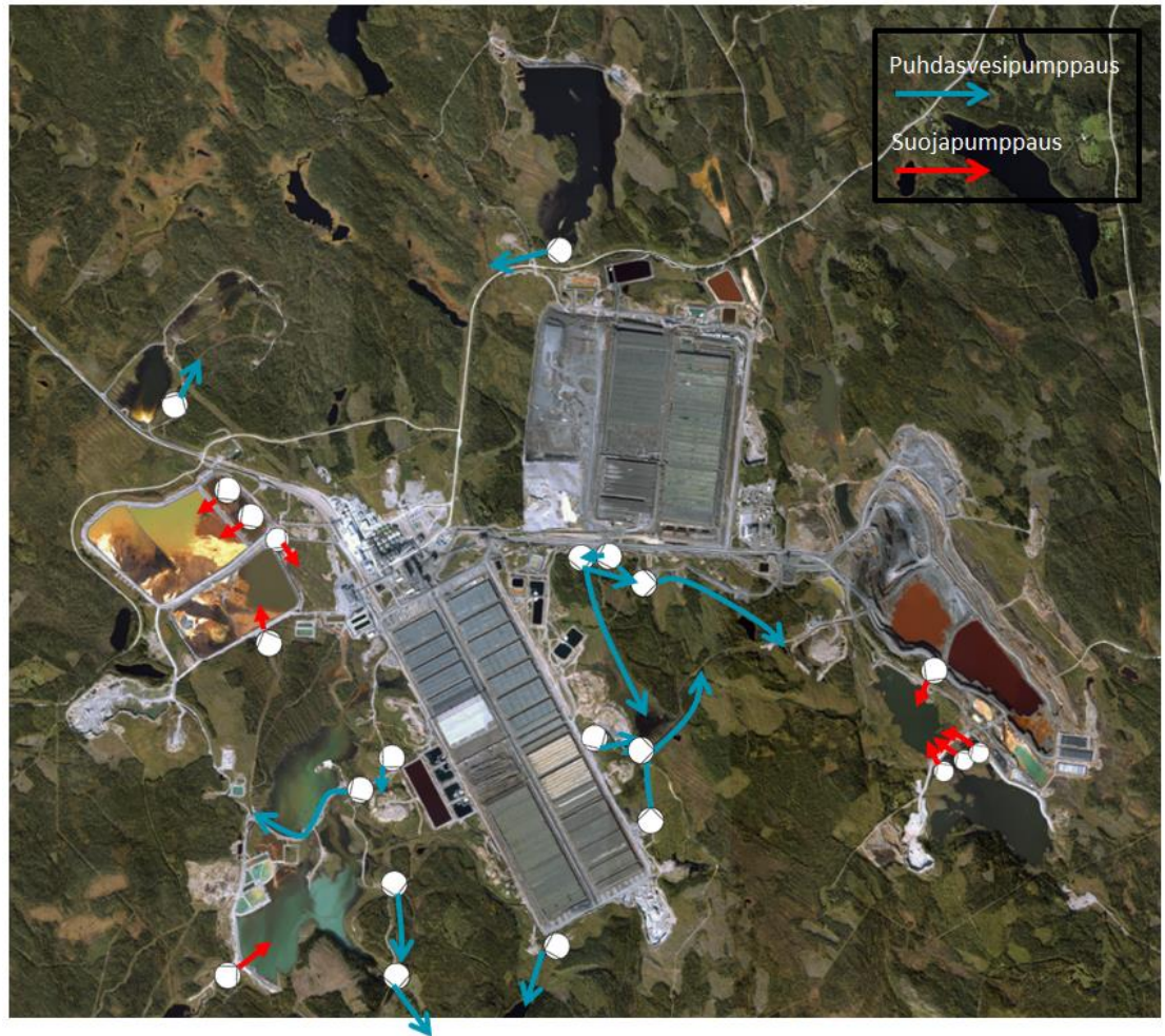
Kuva 7. Suojapumppaukset (suotovesi) ja puhdasvesipumppaukset (TerraFame Oy).
